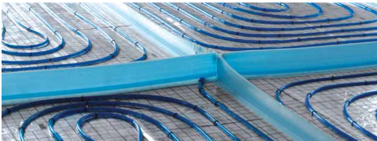
Obr. 14. Rozdělení topných polí dilatačními spárami
