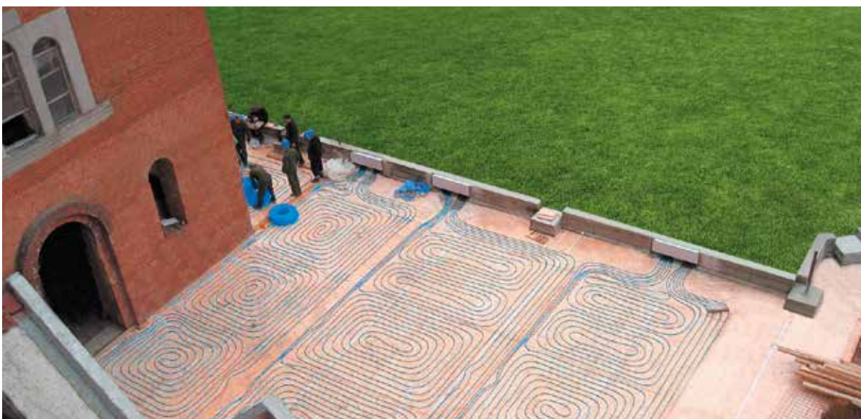
Obr. 5. Instalace venkovního vytápění terasy s využitím trubek bluePERT systému KAN-therm.
