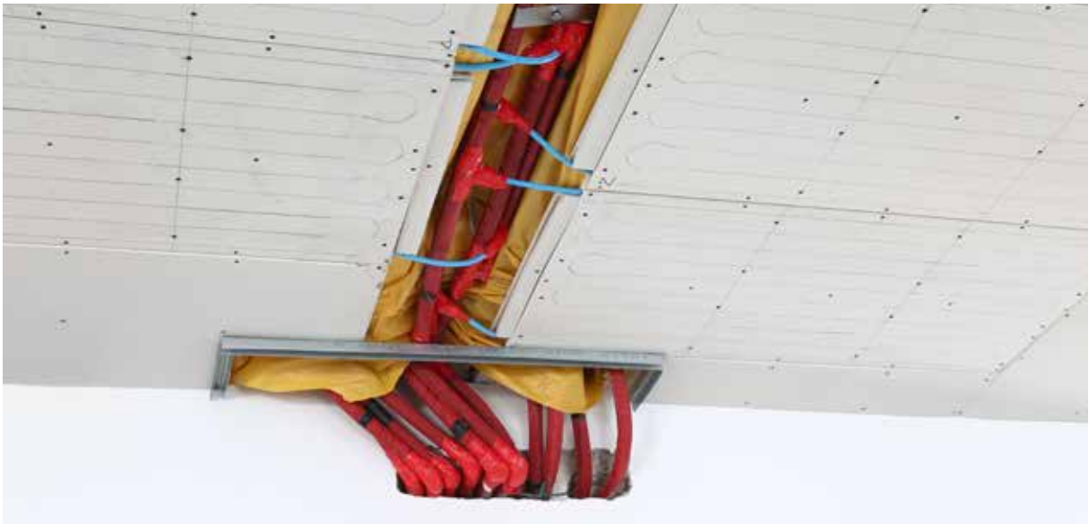
Obr. 6. Instalace stropního chlazení s využitím topných a chladících desek systému KAN-therm Wall.
