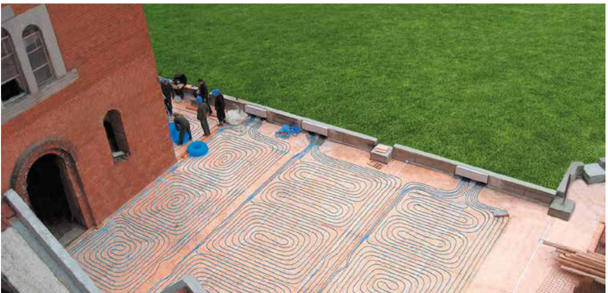
Obr. 5. Instalace venkovního vytápění terasy s využitím trubek bluePERT systému KAN-therm.
