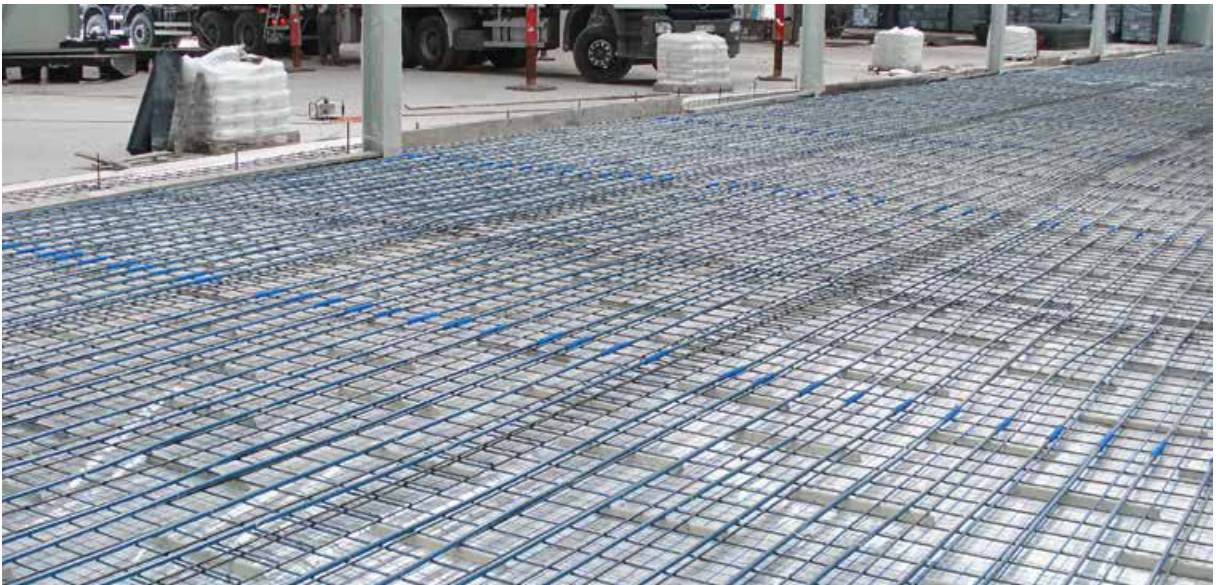
Obr. 4. Instalace podlahového topení ve skladové hale s využitím trubek bluePERT a systém KAN-therm NET.
