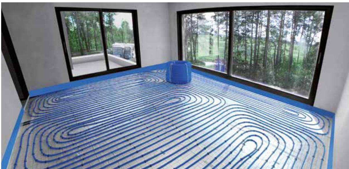
Obr. 3. Instalace podlahového topení v rodinném domě, s využitím trubek bluePERT a systému KAN-therm Tacker.
