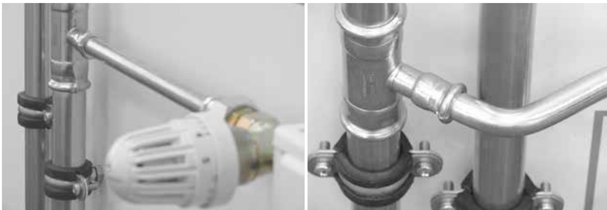
Připojení radiátoru (přívodní a vratná odbočka) ze systému KAN-therm Steel
